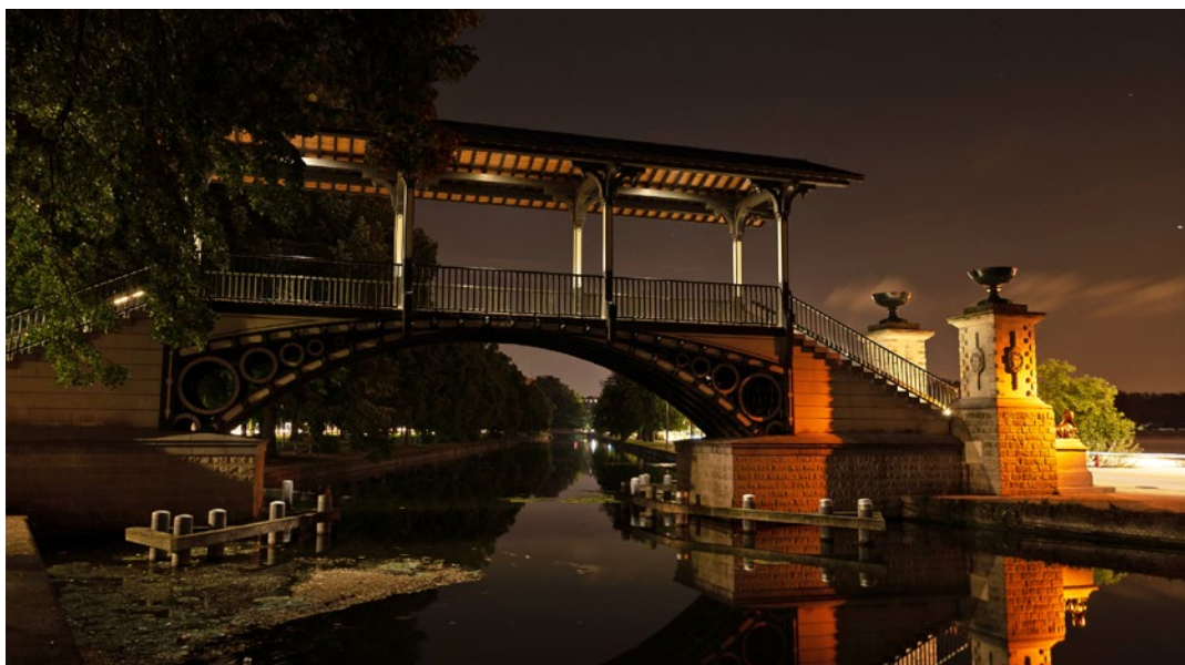
L'éclairage de mise en valeur du pont Napoléon, qui enjambe la Moyenne-Deûle à Lille, est encastré pour éviter l'éclairage direct de l'eau, et de couleur orangée pour limiter le dérangement de la faune nocturne
